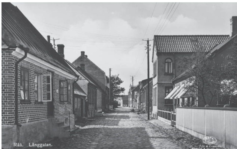
Jonassons hus bytte skepnad på 1930-talet. Kaptenshusen 18 och 20 syns i gatans förlängning t.h.
